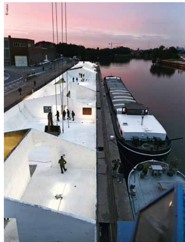
Aménagement des bacs à gravier des docks de Gand, Belgique, 2012.
